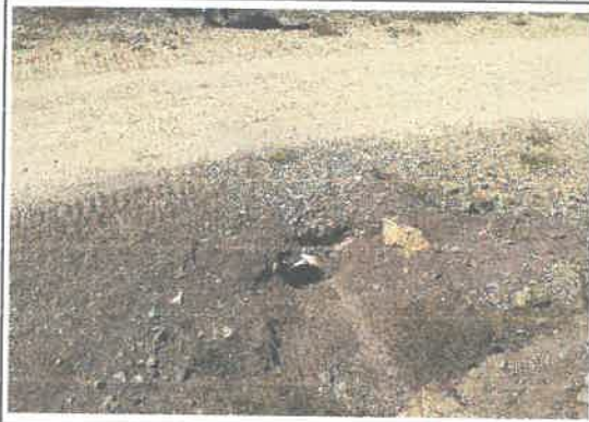
Foto 13: KM 7+700 al 7+750, cruce de agua
