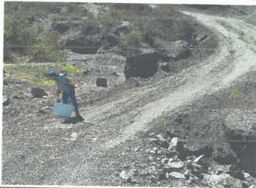
Foto 31: KM 13+800 al 13+850, cruce de Agua
