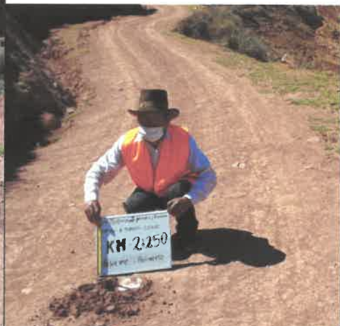
FOTO N° 02 : Ausencia de Material de afirmado.
