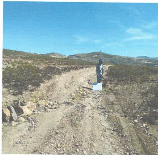
FOTO N° 1: No existe Afirmado.
