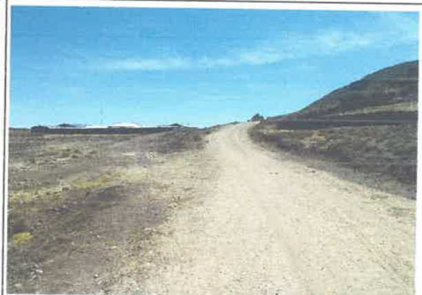
foto 02: KM 3+000 al 6+000, no se cuenta con señalización.
