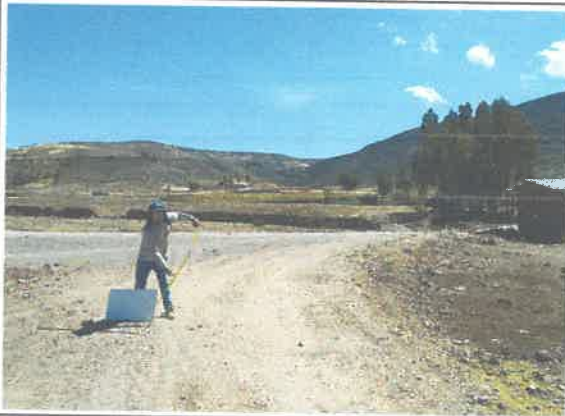
foto 15 KM 11+000 al 11+500, escarpado.
