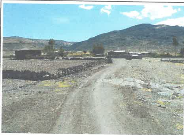
foto 03: KM 6+000 al 9+000, no se cuenta con señalización
