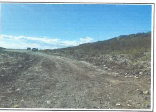
foto 12: KM 4+950 al 5 + 500 escarpado.
