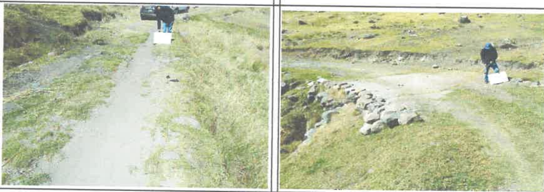
foto 01: KM 01+000 al 01+300, intervencion con obras hidraulicas.
