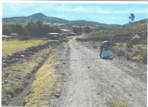
foto 06: KM 03+00 al 3 +500, escarpado.
