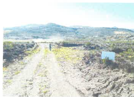
Foto: No se encontraron Alcantarillas ni Tagueas en este tramo.
