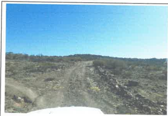
foto 01: KM 0+000 al 0+500, erosion.
