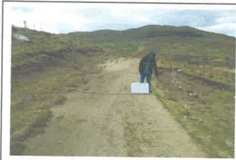
Foto 11: KM 02 + 0000 al 02 + 500erosion-baches.
