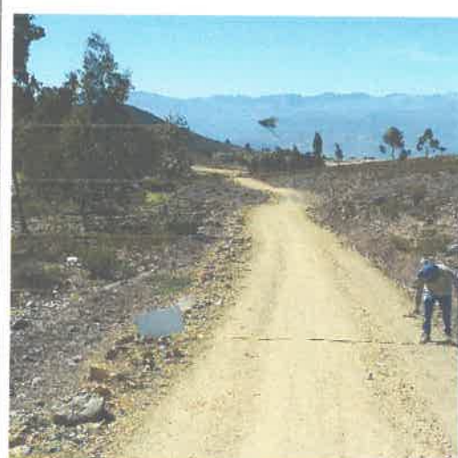
FOTO N° 4: Afirmado en buen estado
