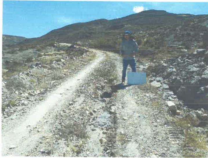
FOTO N° 07 Se puede apreciar el estado de la superficie de rodadura entre el Km 12 + 001- Km 14 + 114
