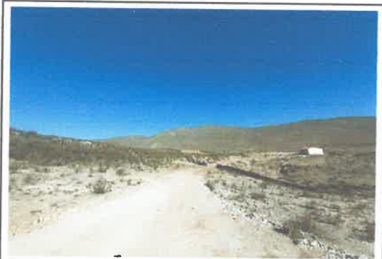
foto 02: No se ubico SEÑAL INFORMATIVA en el kilometro KM 2+350.
