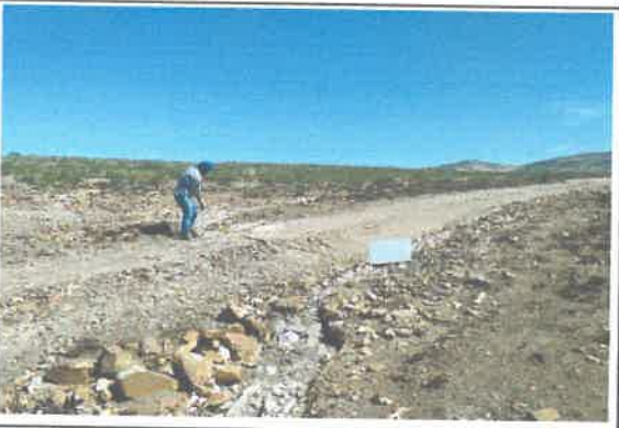
foto 05: KM 05 + 600,bajada de agua.
