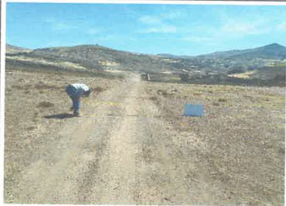
foto 02: patio de maquina KM 0 +450.
