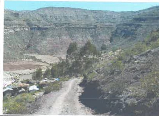
Foto 34: KM 14+350 al 14+900, Erosion
