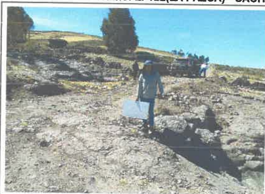
Foto 07: KM 4 +400 al 4+450, Cruce de Agua
