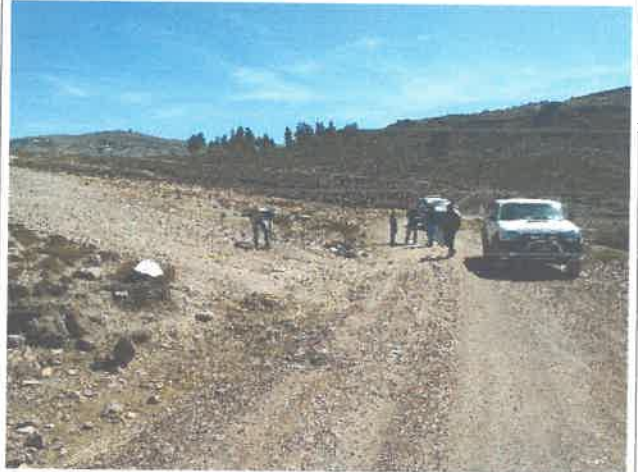
FOTO N° 02: Emp. RVV LI 122 – Inicio Km 0+000 falta señal informativa
