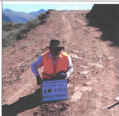
FOTO N° 02 : Ausencia de Material de afirmado.
