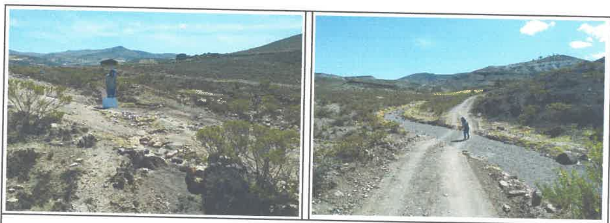
foto 01: bajada de agua KM 01 + 950, necesita obra hidraulica.
