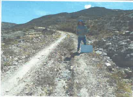
Foto 15: KM 9+400al 9+450, Cruce de Agua
