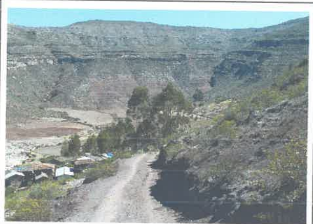
foto 04: KM 9+000 al 15+469, no se cuenta con señalización.
