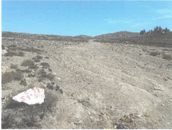
Inicio de la carretera KM 0+000 – Emp. Red Vial Vecinal LI 122 KM 59+500 - Sector Cruz la Pazca.
