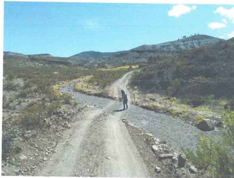
FOTO 04: Implementación de Cunetas.
