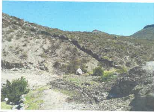
Foto 33: KM 14+300 al 14+350, Cruce de Agua
