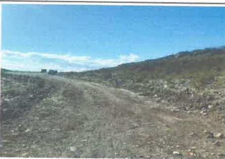
foto 05: KM 1+0400 al 01 +550 baches.
