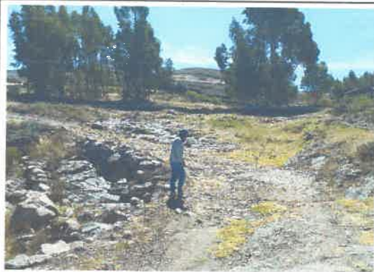
Foto 05: KM 2 + 650 al 2 + 770, cruce de agua.
