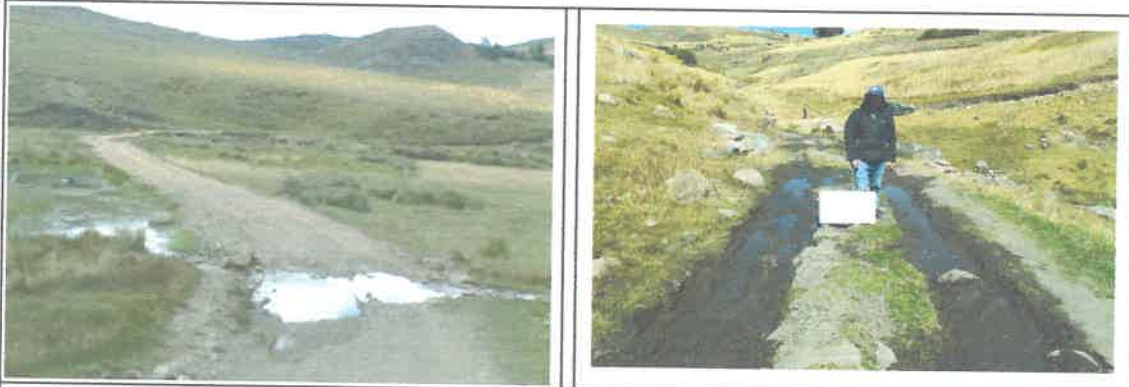
foto 01: KM 01+000 al 01+300, intervencion con obras hidraulicas.
