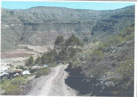
foto 21 KM 14+000 al 14+500, ondulado.
