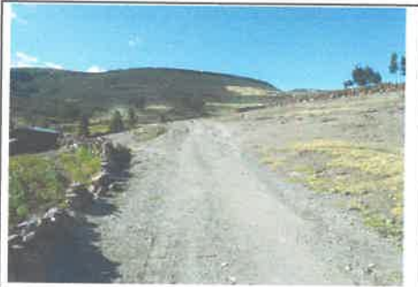
Foto 14: KM 03 + 500 al 04 + 000erosion-baches
