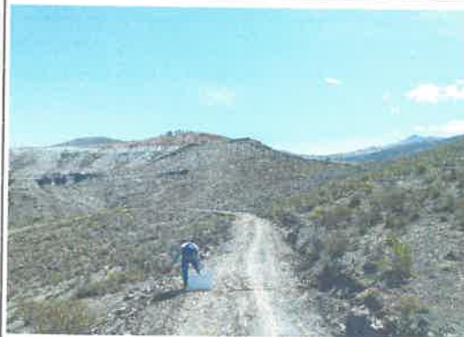
Foto 22: KM 11+450 al 11+650, erosion - Baches
