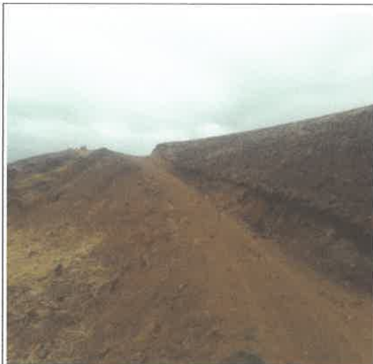
FOTO N° 01: No existe Afirmado.
