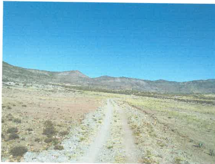
FOTO N° 02. No se identificó la presencia de obras de drenaje 2+000 TRAMO 0+000- 2+250
