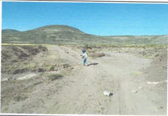
foto 03: KM 01 + 700 bajada de agua.
