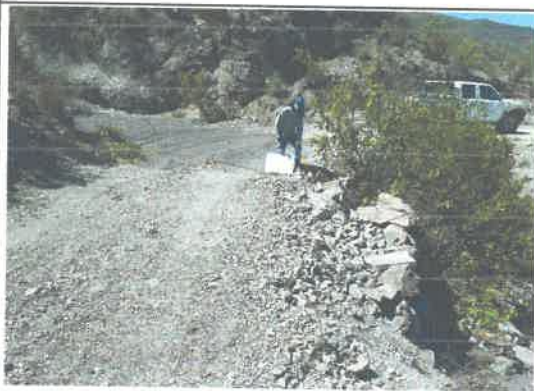
Foto 21: KM 11+400 al 11+450, Cruce de Agua
