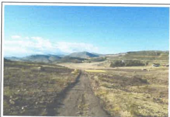
foto 03: No se ubico POSTES KILOMETRICOS en todo el tramo KM 0+000 al KM 2+350.
