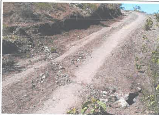
Foto 35: KM 14+900 al 14+950, Cruce de Agua
