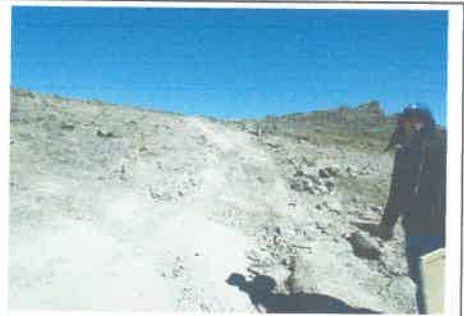
Foto 16: KM 04 + 500 al 04 + 950 cruce de agua
