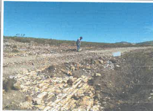
foto 02: 00 + 200 al 00 + 250, cruce de agua.
