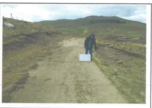
foto 08: KM 2+950 al 3 + 550 escarpado.
