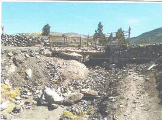
Foto 17: KM 10+250 al 10+300, Cruce de Agua
