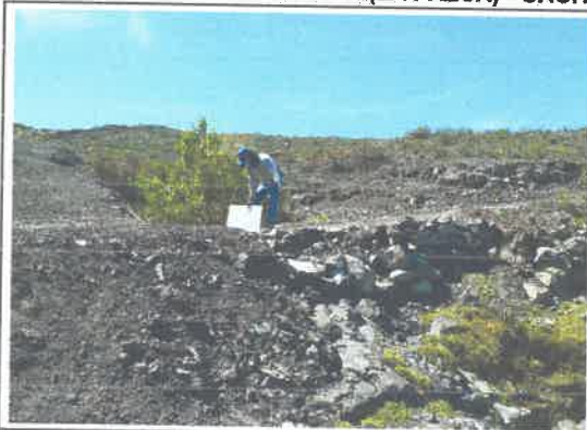
Foto 19: KM 11+000 al 11+050, Cruce de Agua
