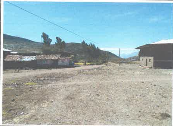
foto 04: patio de maquina KM 10 +450.
