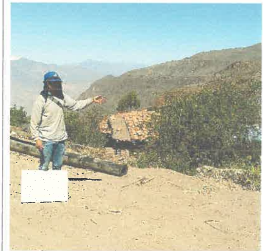
FOTO N° 12: Ausencia de Material de afirmado.
