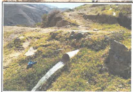
foto 14: bajada de agua KM11+075, no requiere cambiar.
