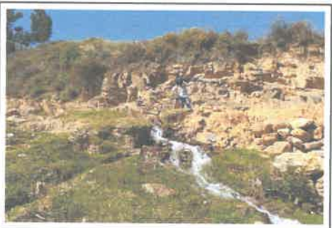
foto 39: KM 11+400 al 11+450, Presencia de cruce de agua (6).
