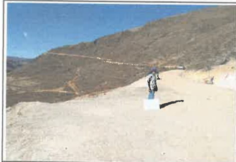
foto 17: KM 3+200a al 3+600, Presencia de encaliminado y bache (4-3).
