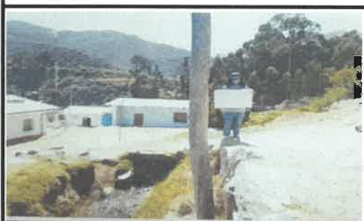
Foto 03:SEÑAL INFORMATIVA KM15+000,CP Oyon no existe señal informativa
