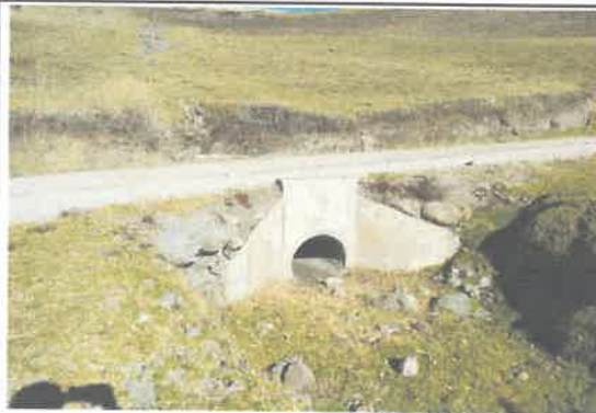
foto 03: canal, KM 05+043, alcantarilla.
