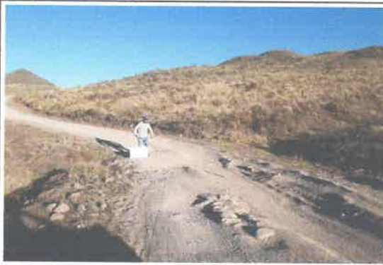
foto 16: KM 08+750 al 11 + 050,cuneta.
