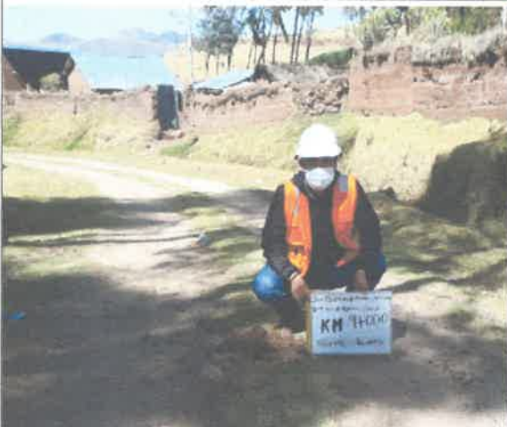
FOTO N° 14: Desgaste de capa de rodadura (afirmado).
