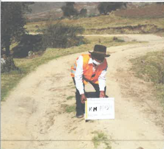
FOTO N° 20: Desgaste de capa de rodadura (afirmado).
