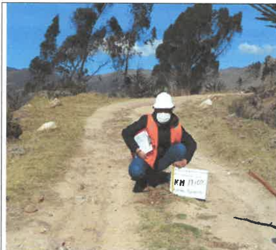
FOTO N° 13: Perdida o Ausencia de Material de afirmado.
