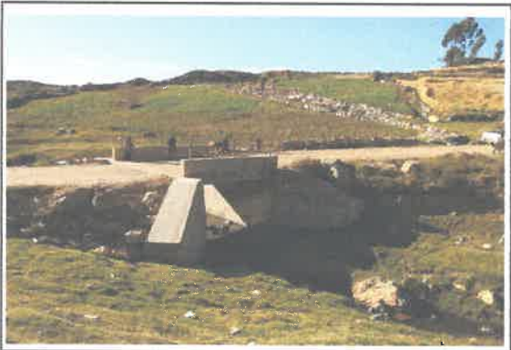
foto 01: KM 0+775, Ponton tipo loza de concreto estructuralmente bueno y en buen funcionamiento
