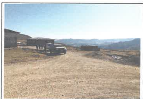
foto 02: 0+000 AL 0+800, Presencia Presencia de deformacion y Baches (1-3).
