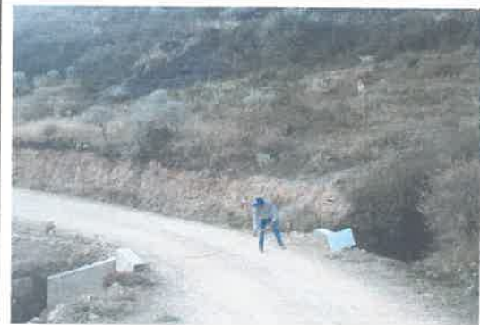
Foto 04: KM 00+200 al 05 +444 alcantarilla.
