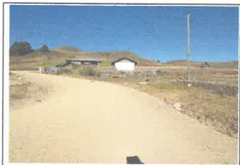
foto 01: KM 0 + 000 AL 0+750, Presencia de deformacion y Baches (1-3).
