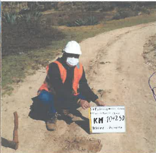
FOTO N° 17: Desgaste de capa de rodadura (afirmado).
