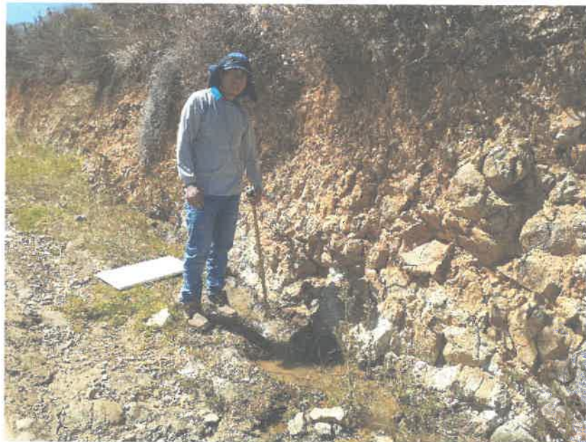
FOTO N° 04. Se requiere limpieza y mantenimiento de cunetas
