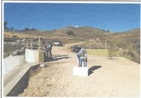
foto 09: KM 1+450 AL 1+600 Presencia de encaliminado y bache (4-3).
