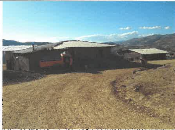
FOTO N° 01: foto Km 00+000 no hay ningún tipo de señales.
