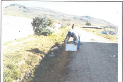
foto 03: KM 0+800 AL 0+850 al , Presencia de encaliminado y bache (4-3).
