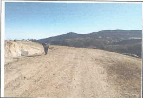
foto 19: KM 4+000 al 4+500, Presencia de encaliminado y bache (4-3).
