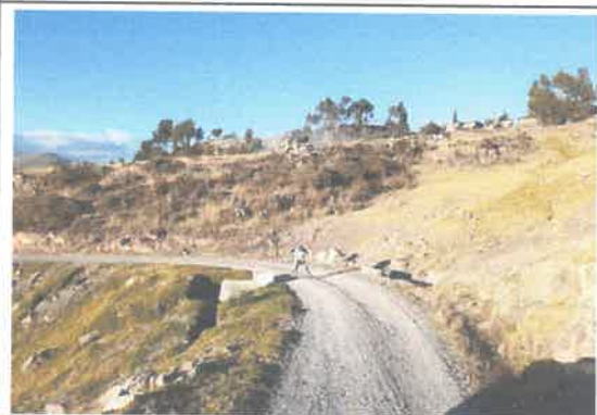
foto 15: KM 04+100 al 08 + 700,cuneta.
