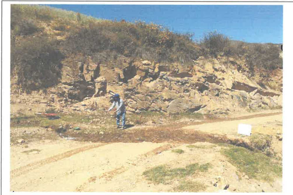
foto 01: KM 06+951.57, cruce de agua.
