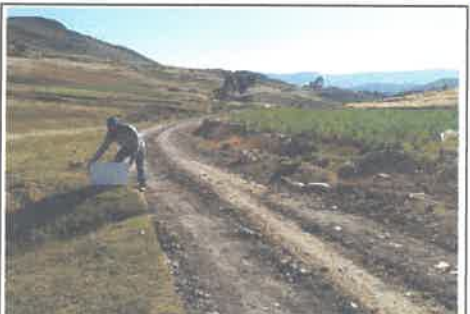
foto 06: KM 1+100 al 1+150, Presencia de encaliminado y bache (4-3).
