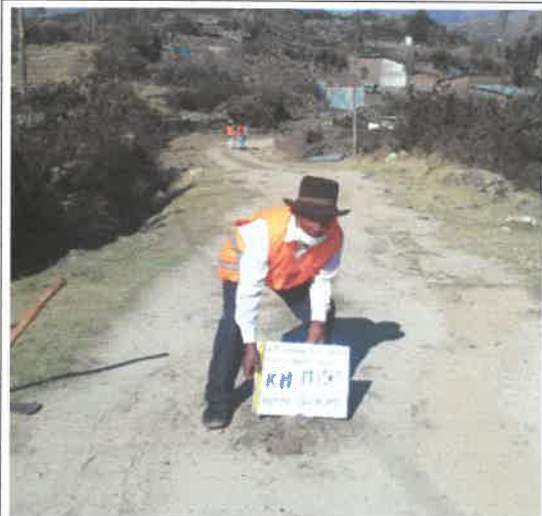
FOTO N° 15: Perdida o Ausencia de Material de afirmado.
