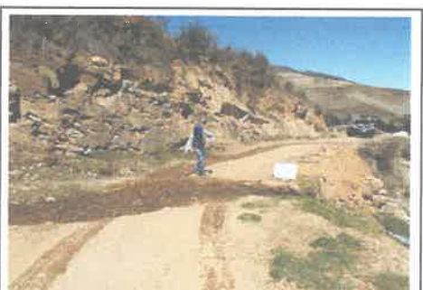
foto 30: KM 7+700 al 7+750, Presencia de cruce de agua (6)
