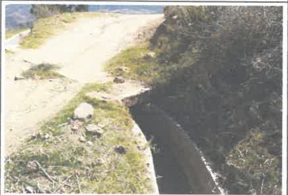
foto 09: canal, KM 05 + 980 no requiere intervencion.
