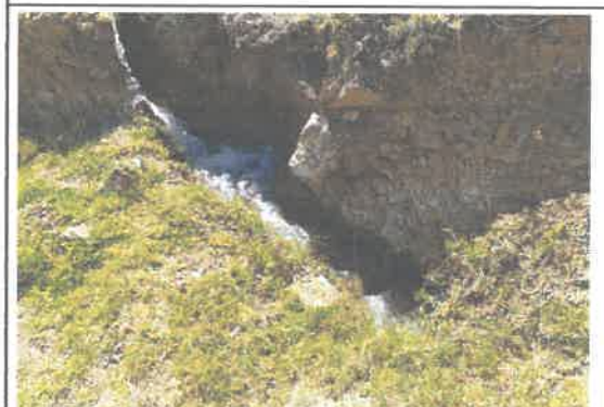
foto 16: bajada de agua KM 11+705, no requiere cambiar.
