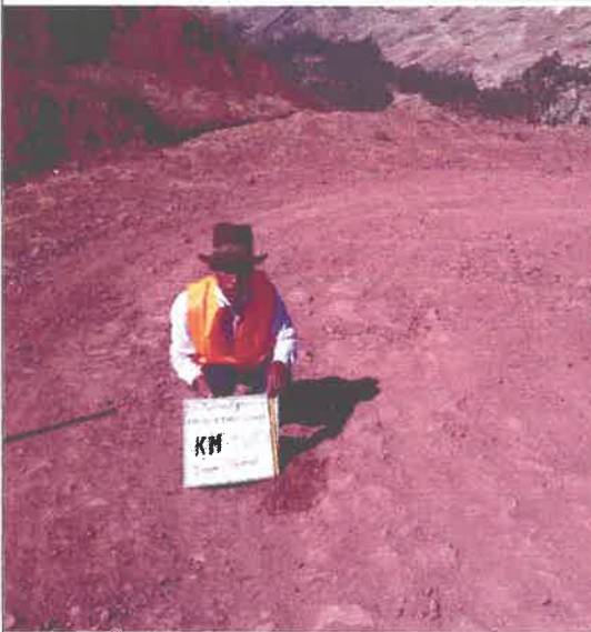
FOTO N° 03: Desgaste de capa de rodadura (afirmado).
