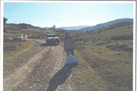
foto 07: KM 1+150 AL 1+400, Presencia de encaliminado y bache (4-3).
