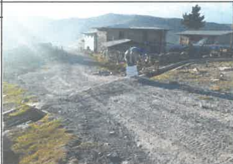
foto 14: KM 6+000 al 6+500deformacion - encalaminado.
