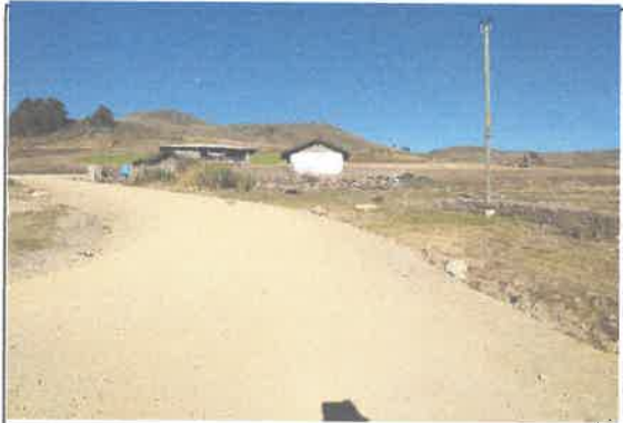
foto 1: Cuneta KM 0+800 al 1+000, se encuentra en buen estado.
