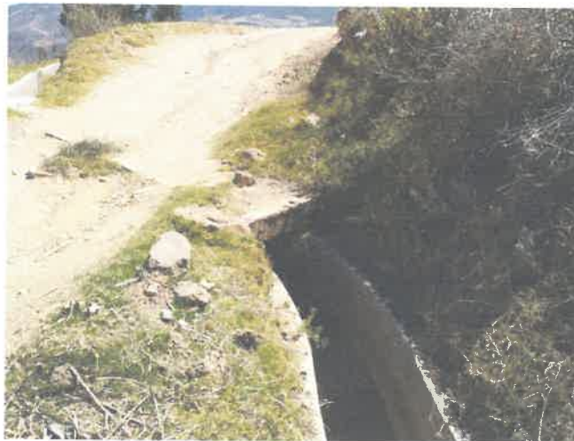
FOTO N° 05: Vista de la fuente de agua-Canal de riego
