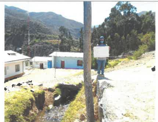
FOTO N° 02: foto final Km 15 + 000 no hay ningún tipo de señales.
