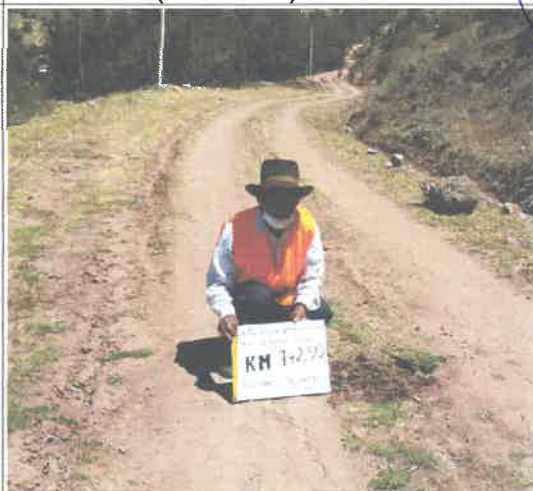
FOTO N° 8 Desgaste de capa de rodadura (afirmado).
