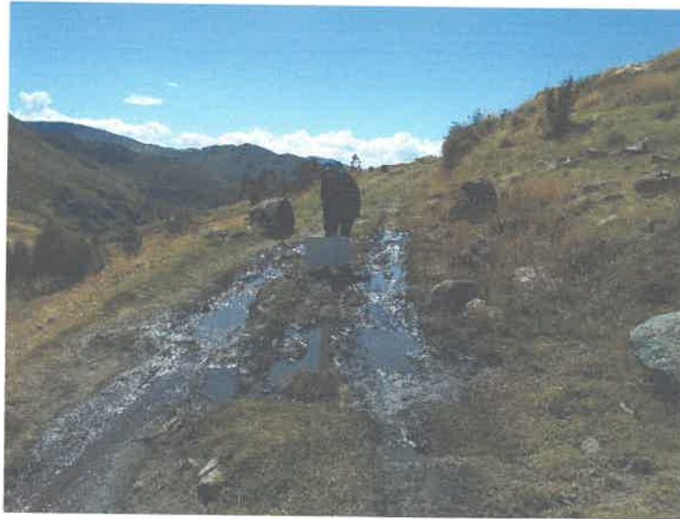
FOTO N° 04. Progresiva 1+600 implementar alcantarilla
