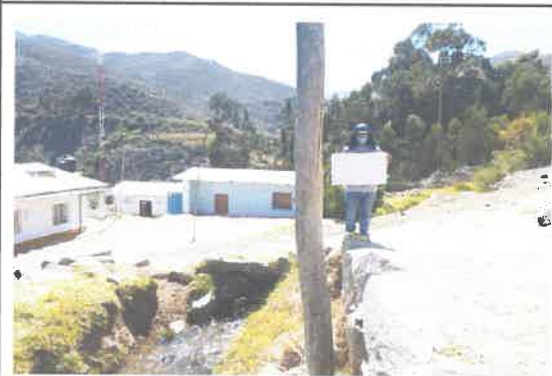
foto 17: bajada de agua KM 13+836, no requiere cambiar.
