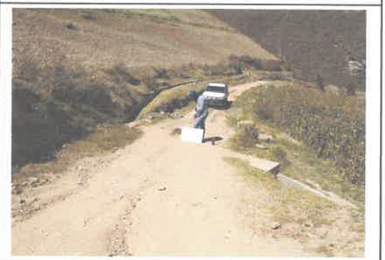
foto 10: Pase de canal KM 06 + 388, se encuentra en buen estado.
