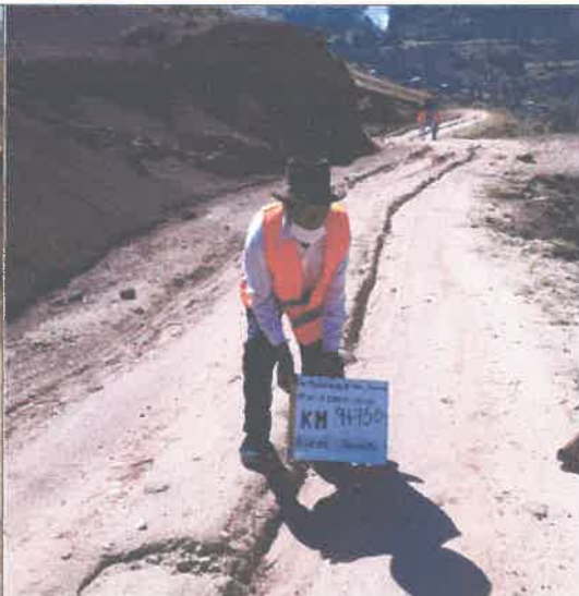
FOTO N° 17: Desgaste de capa de rodadura (afirmado).
