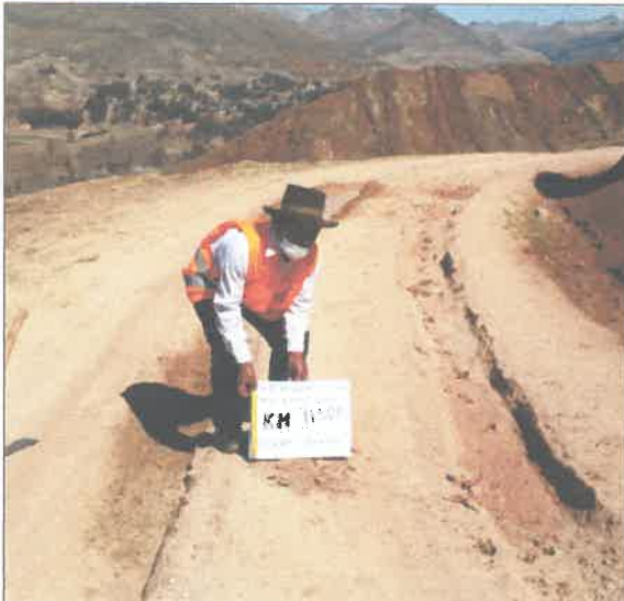
FOTO N° 16: Desgaste de capa de rodadura (afirmado).
