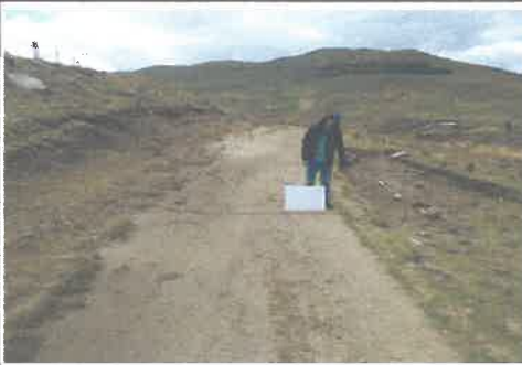
foto 13: KM 5+500 al 6+00, deformacion encalaminado.
