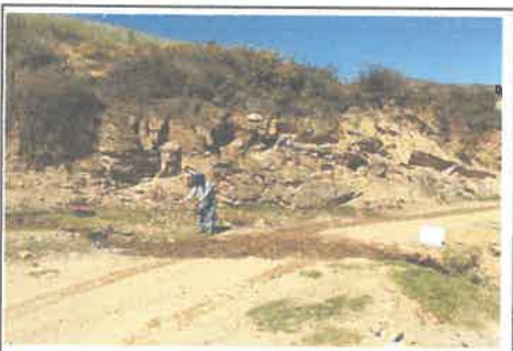
foto 37: KM 11+000 al 11+050, Presencia de cruce de agua.
