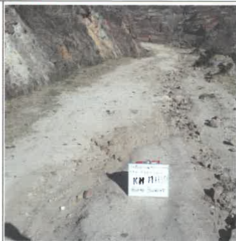
FOTO N° 18: Perdida o Ausencia de Material de afirmado.
