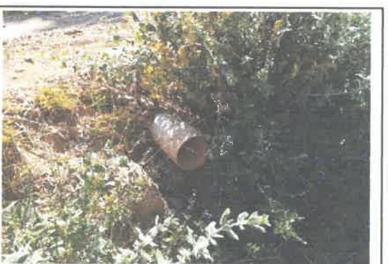
foto 12: KM 07 + 323, canal no necesita cambiar.
