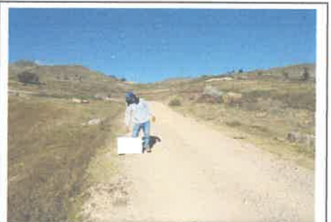
foto 08: KM 1+400 AL 1+450 Presencia de encaliminado y bache (4-3).
