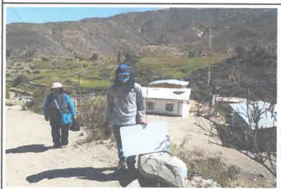
foto 17: bajada de agua KM 13+836, no requiere cambiar.
