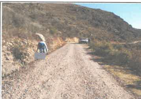
foto 13: KM 1+850 al 2+200, Presencia de encaliminado y bache (4-3).
