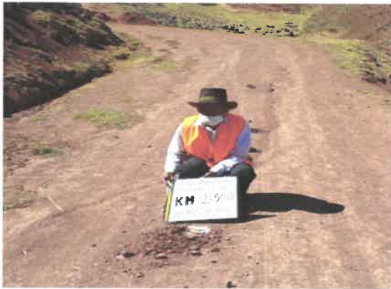
FOTO N° 11: Perdida o Ausencia de Material de afirmado.
