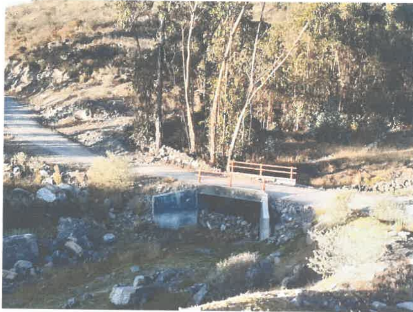
FOTO N° 04. Se requiere limpieza y mantenimiento de cunetas
