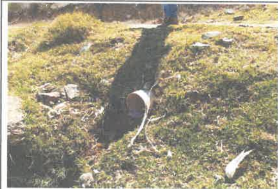
foto 15: bajada de agua KM 11+455, no necesita cambiar.
