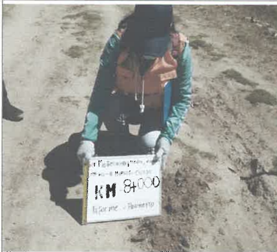
FOTO N° 10: Desgaste de capa de rodadura (afirmado).
