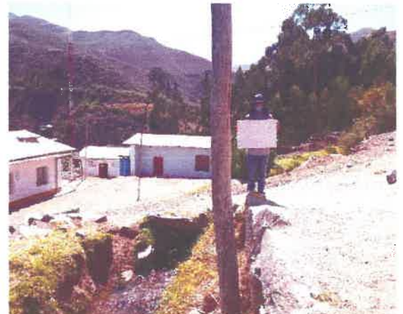
FOTO N° 02: foto final Km 13+000 no hay ningún tipo de señales.
