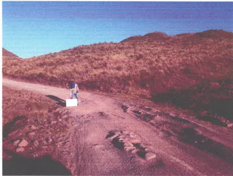
FOTO N° 05 Se puede apreciar el estado de la superficie de rodadura entre el Km 8+ 001- Km 10 + 000
