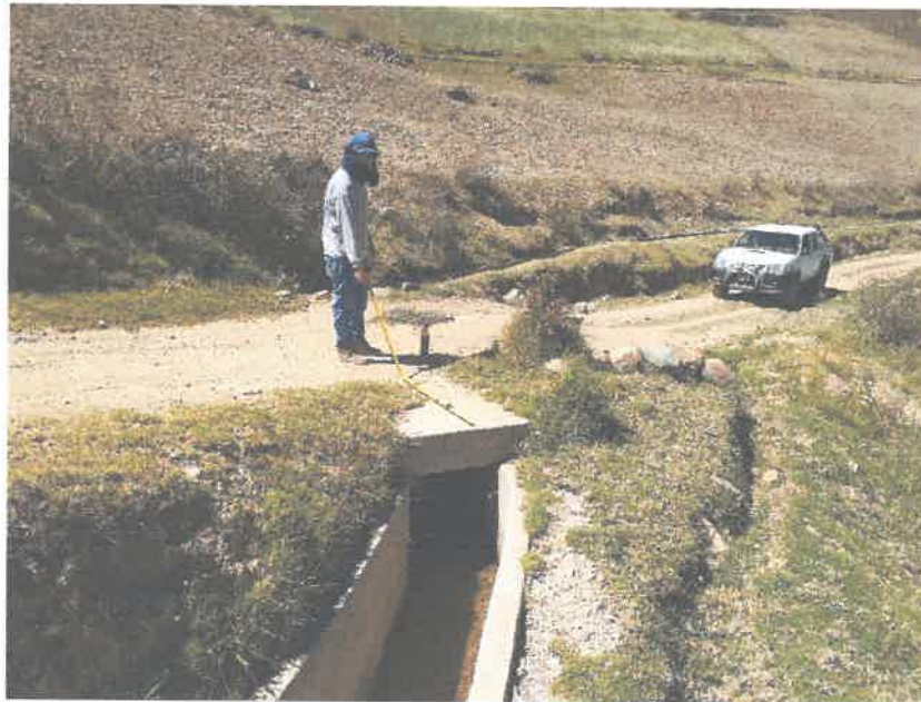
FOTO N° 04. Se requiere limpieza y mantenimiento de cunetas
