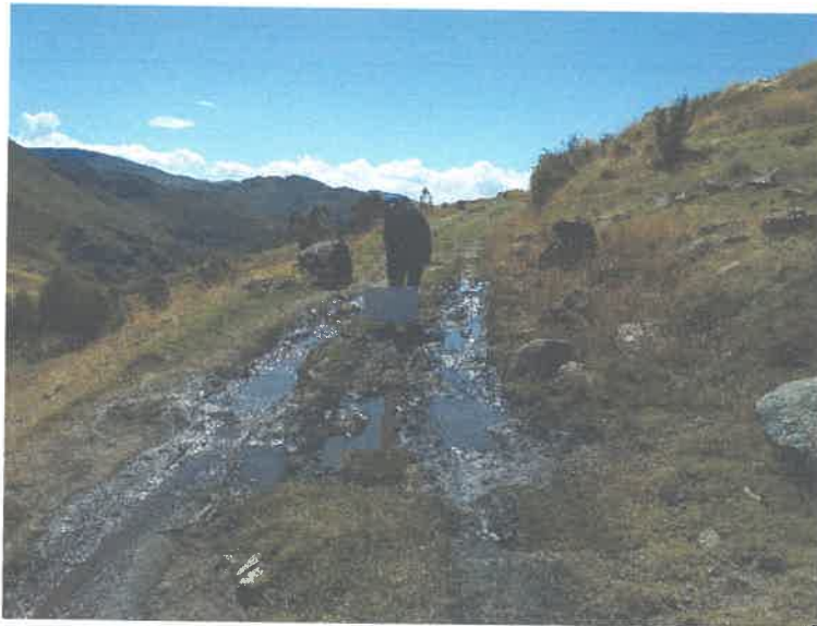
FOTO N° 04. Progresiva 1+600 implementar alcantarilla
