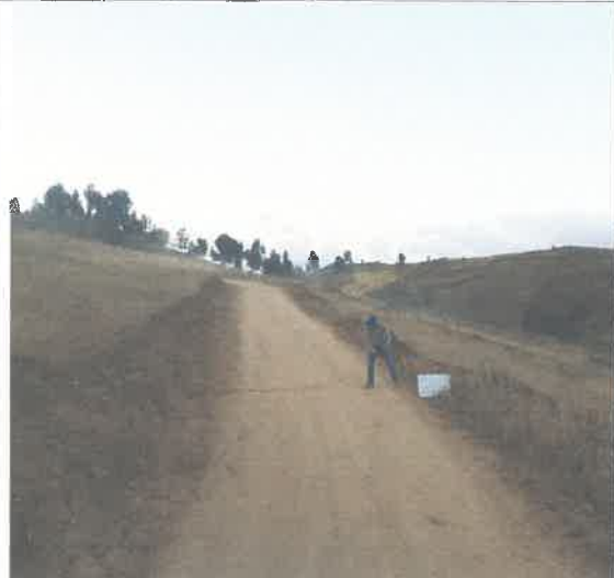
FOTO N° 12: Desgaste de capa de rodadura (afirmado).
