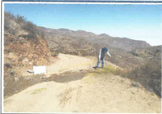
foto 13: KM 7+750, canal no necesita cambiar.
