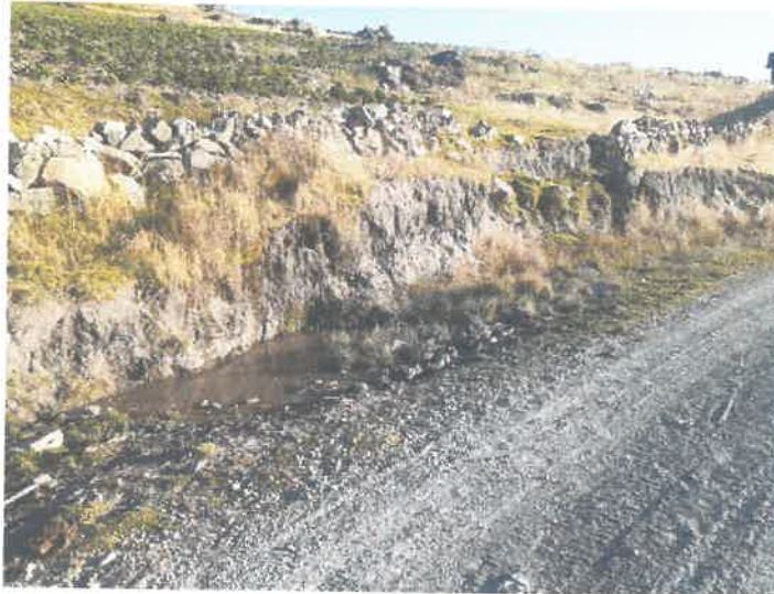
FOTO N° 02. Progresiva 0+800 implementar alcantarilla
