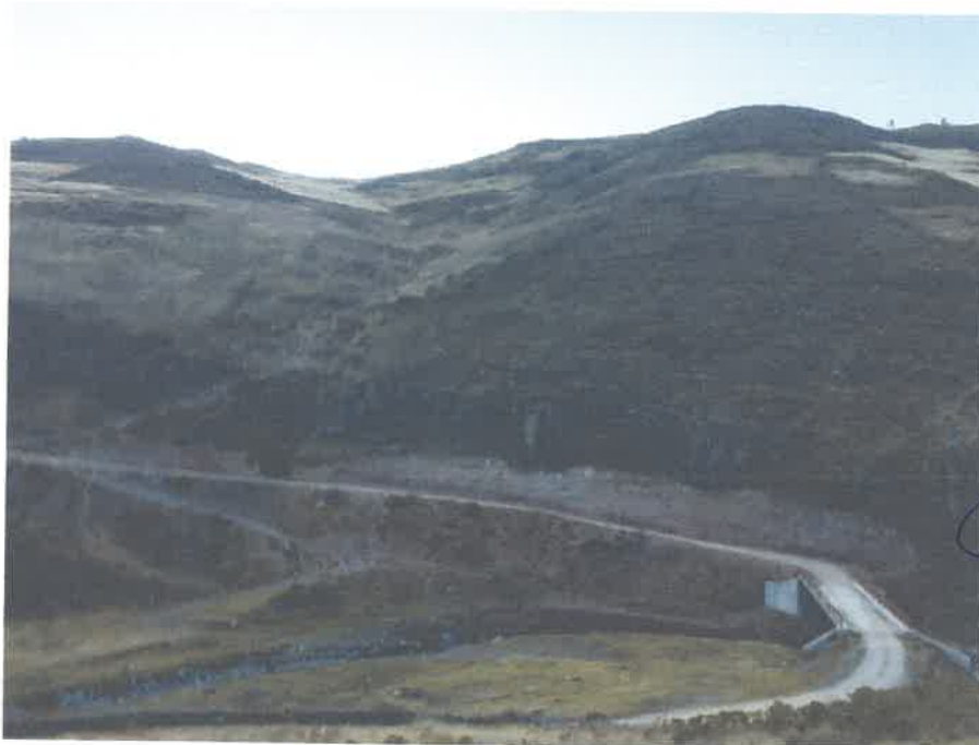
FOTO N° 01: Vista de la fuente de agua-Quebrada
