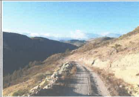
Foto 10: KM 3+500 al 4+000, erosion y baches.
