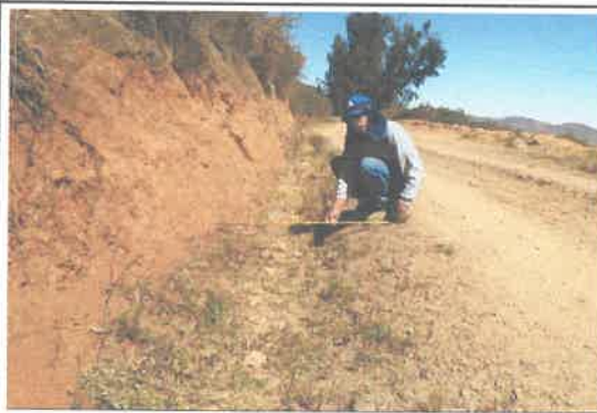
foto 14: KM 03+100 al 04 + 050,cuneta.
