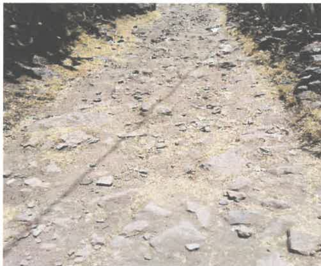
Punto final del tramo, progresiva km 10++610
