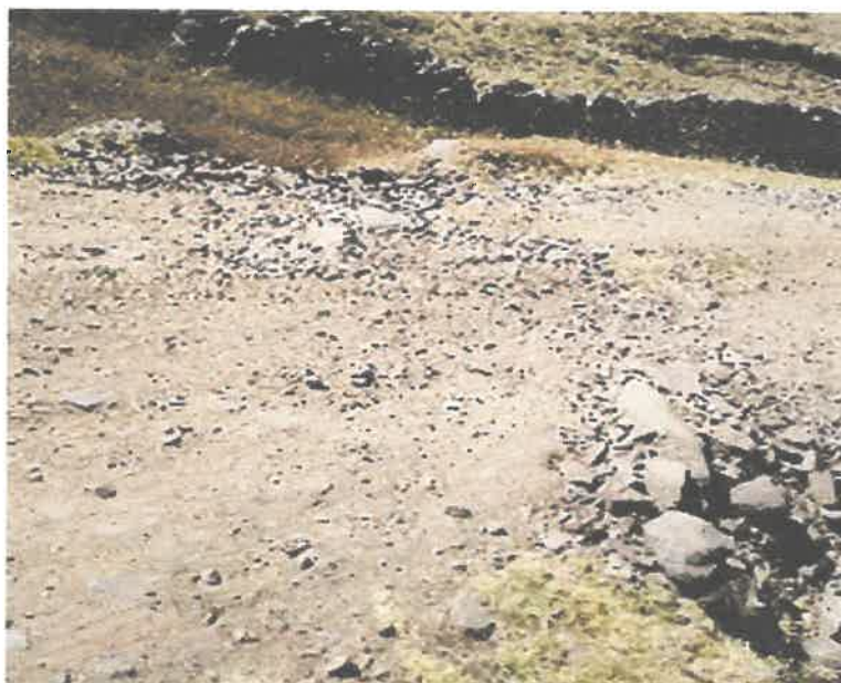
Punto final del tramo, progresiva km 6+200
